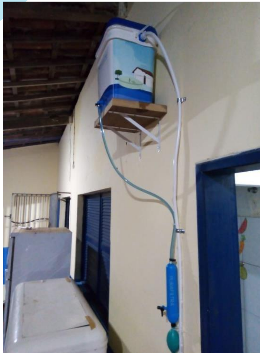
Purafilter com suporte e funcionando. Comunidade Rio dos Índios – Ceará – Mirim - RN/Brasil. Realização: Versati. Ano 2022. Foto: Acervo Versati.
